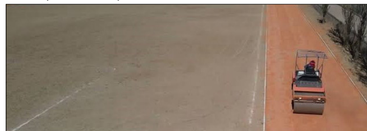
LA CONSTRUCCIÓN DE LA PISTA ATLÉTICA, ESTÁ EN LA RECTA FINAL. (FOTO: ALCALDÍA).
