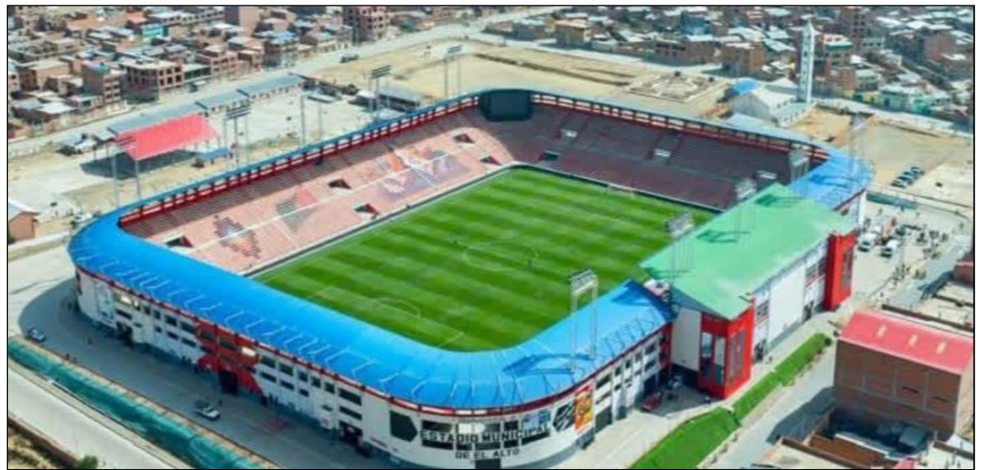
TOMA AÉREA DEL ESTADIO MUNICIPAL DE VILLA INGENIO.
