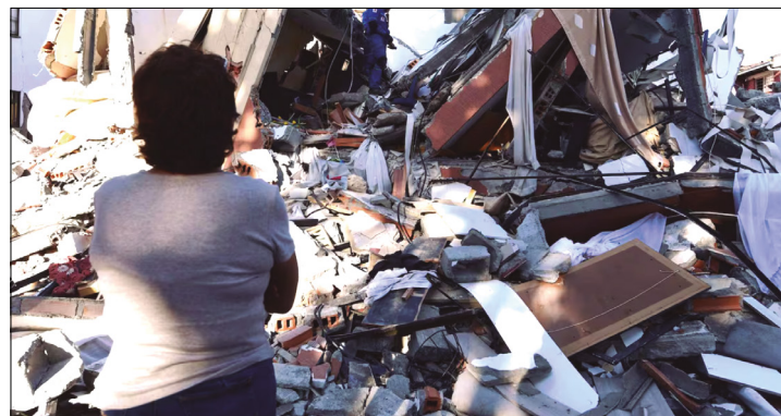
UNA MUJER SIGUE DE CERCA EL TRABAJO DE LOS RESCATISTAS EN UN EDIFICIO CAÍDO EN PEREIRA (ARCHIVO)
