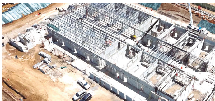
IMAGEN DEL CENTRO DE ALTA CONTENCIÓN DE LA CRIMINALIDAD ORGANIZADA (CACCO) AÚN EN CONSTRUCCIÓN, EN ALAJUELA, COSTA RICA.
