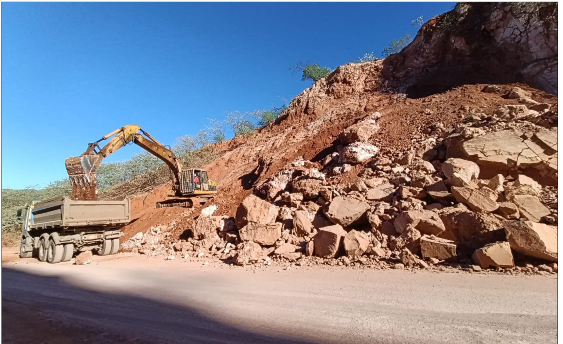
SE REALIZA INSPECCIÓN TÉCNICA DEL TRAMO CANALETAS-ENTRE RÍOS JUNTO A FONPLATA
