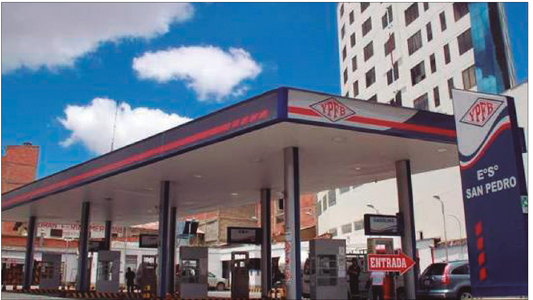
ESTACIÓN DE SERVICIO QUE DISTRIBUYE GASOLINA
