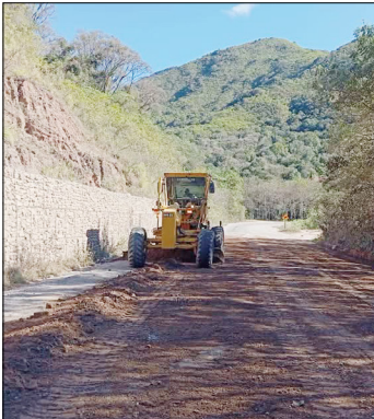
TRABAJOS EN RUTAS DEL DEPARTAMENTO DE TARIJA
