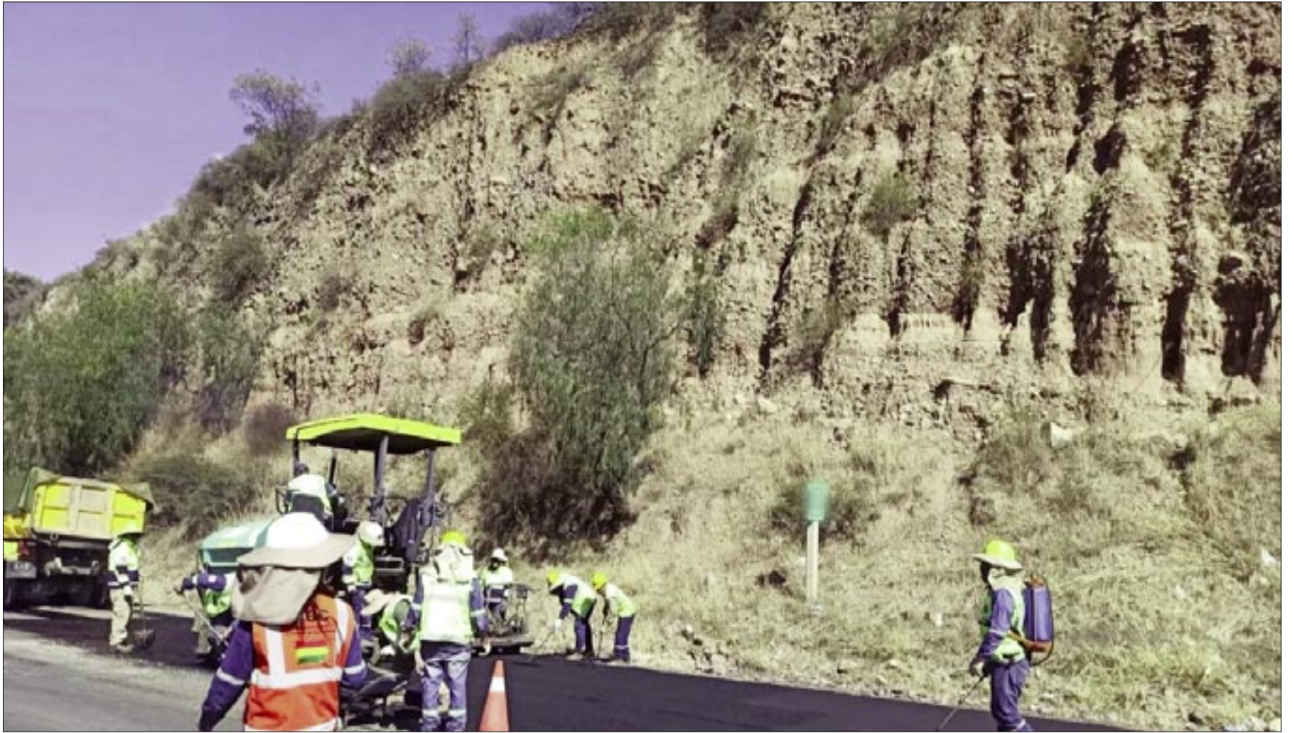
LOS TRABAJOS SE REALIZARÁN DURANTE EL LUNES Y MARTES, 3 Y 4 DE AGOSTO/FOTO: IMAGEN REFERENCIAL
