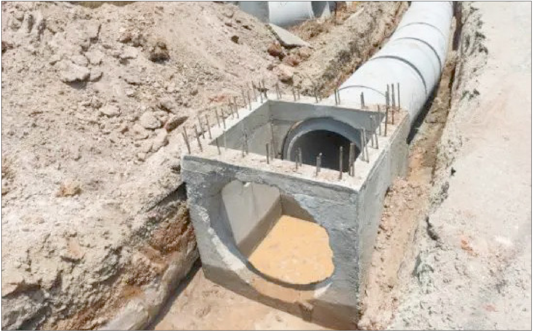
EMAGUA TIENE EN EJECUCIÓN VARIOS PROYECTOS DE ALCANTARILLADO SANITARIO.
