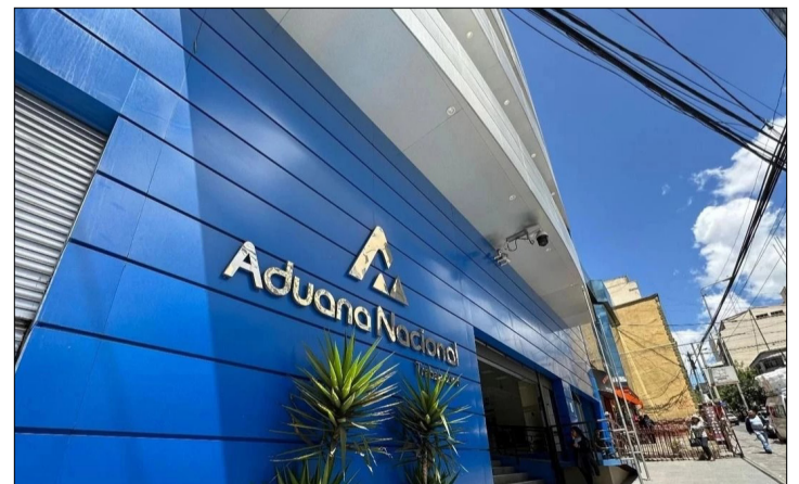
IMAGEN REFERENCIAL DE LA FECHADA DE LA ADUANA NACIONAL
