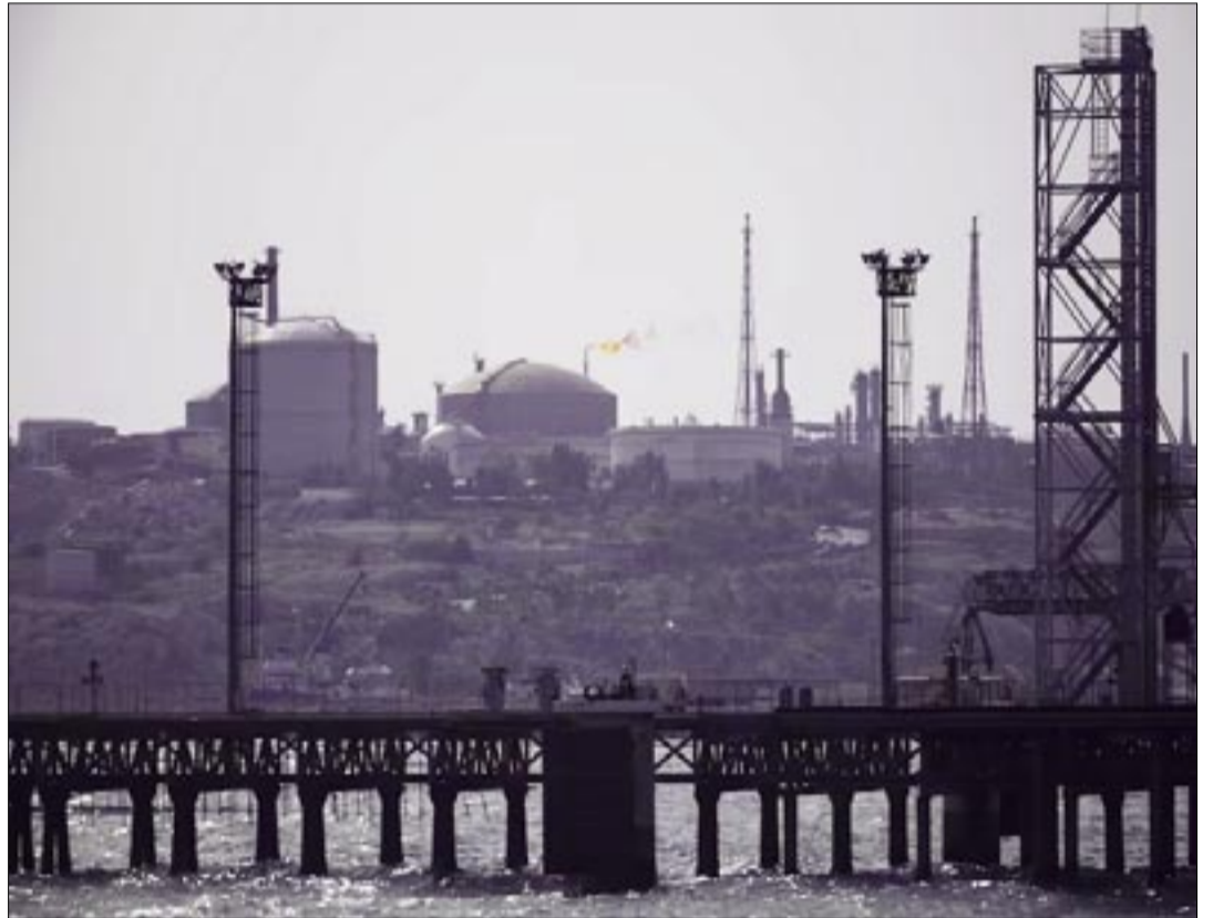
EL MERCADO DEL PETRÓLEO SE PREPARA PARA UNA SEMANA TUMULTUOSA TRAS EL ATAQUE A KHARG. INSTALACIONES ENERGÉTICAS Y TERMINAL PORTUARIA EN LA COSTA DEL GOLFO. EN UNA IMAGEN QUE REFLEJA LA TENSIÓN SOBRE LA INFRAESTRUCTURA PETROLERA REGIONAL
