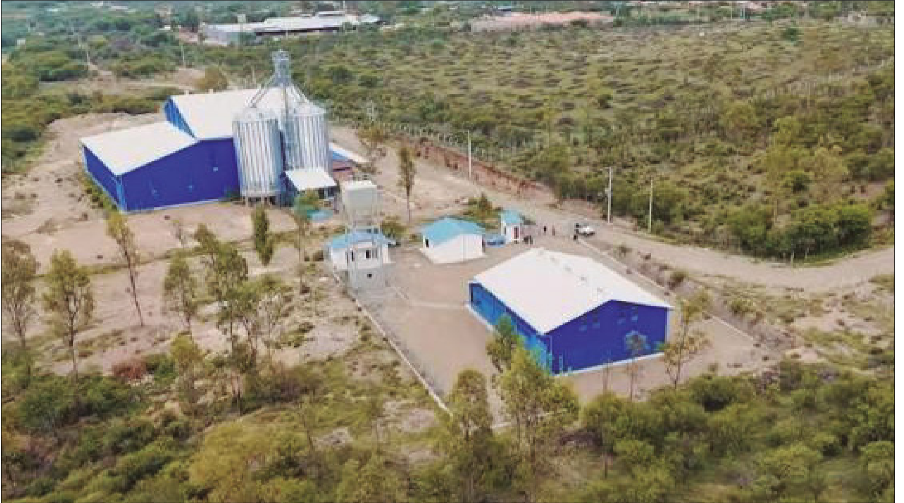
PLANTA EXTRACTORA DE ACEITE DE MANZANILLA QUE NO ESTÁ FUNCIONANDO.
