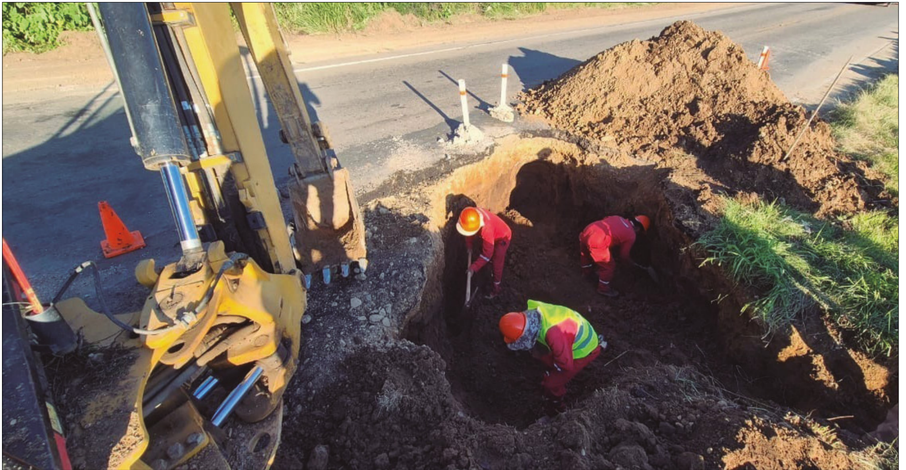
LA ENTIDAD CAMINERA INTENSIFICÓ EL MANTENIMIENTO CAMINERO.
