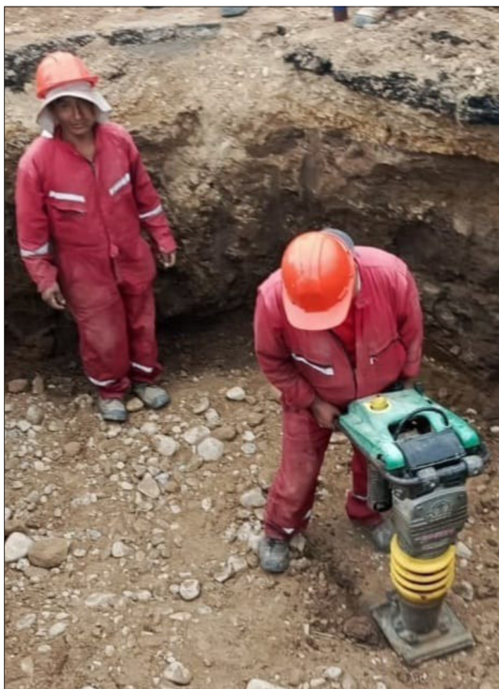
TRABAJADORES DE LA ABC REPARARON TRAMOS VIALES.
