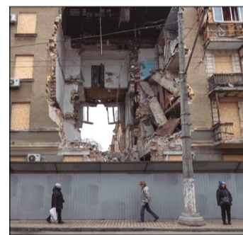
UN EDIFICIO RESIDENCIAL GRAVEMENTE DAÑADO TRAS UN ATAQUE AÉREO, EN ODESSA
