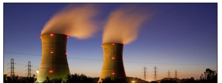
LA CENTRAL NUCLEAR DE THREE MILE ISLAND EN EE.UU., QUE SUFRIÓ UN ACCIDENTE DÉCADAS ATRÁS. GETTY
