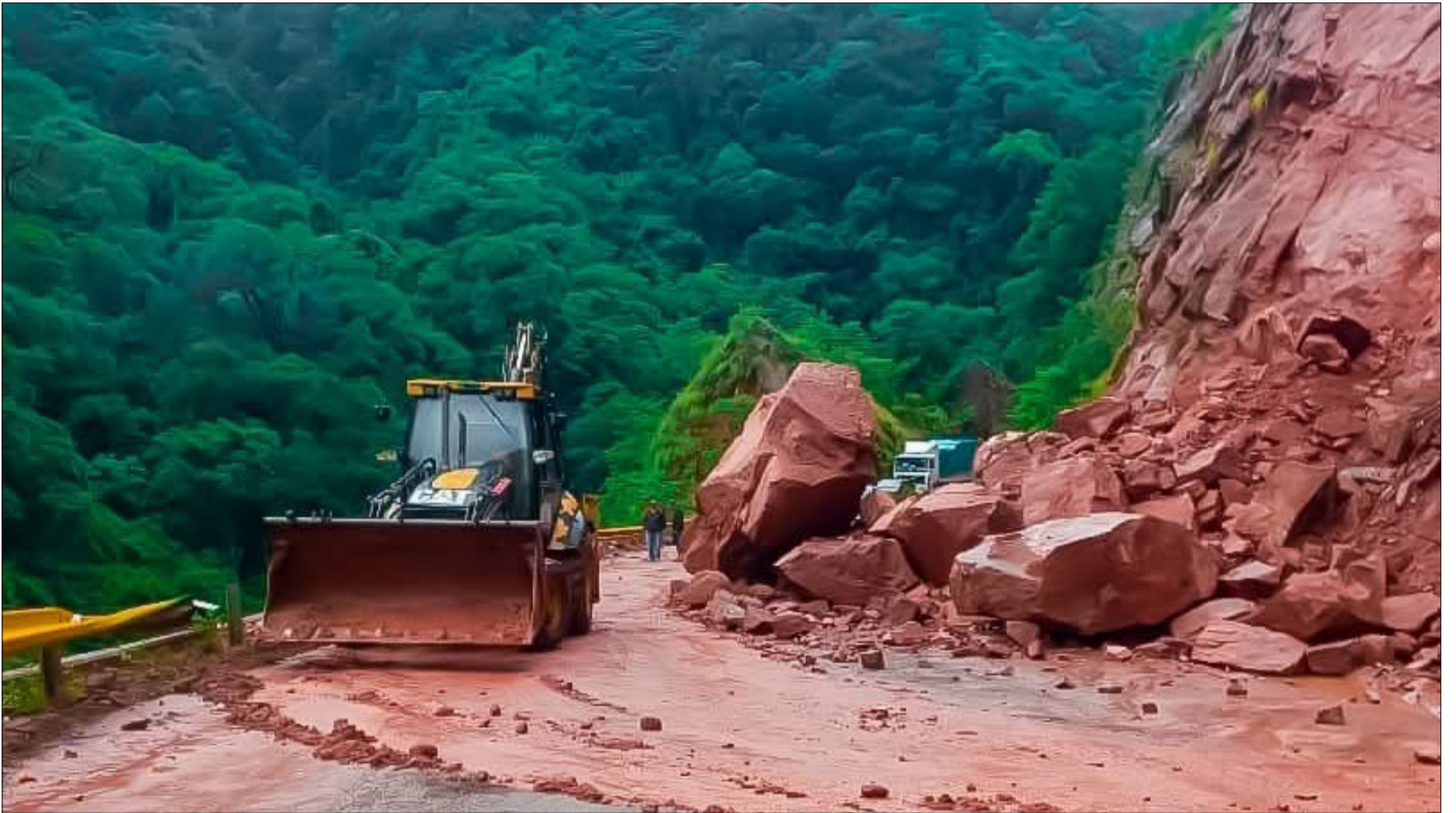
LAS LLUVIAS DE LAS ÚLTIMAS HORAS DESATARON DERRUMBES Y CORTES EN RUTAS TRONCALES.
