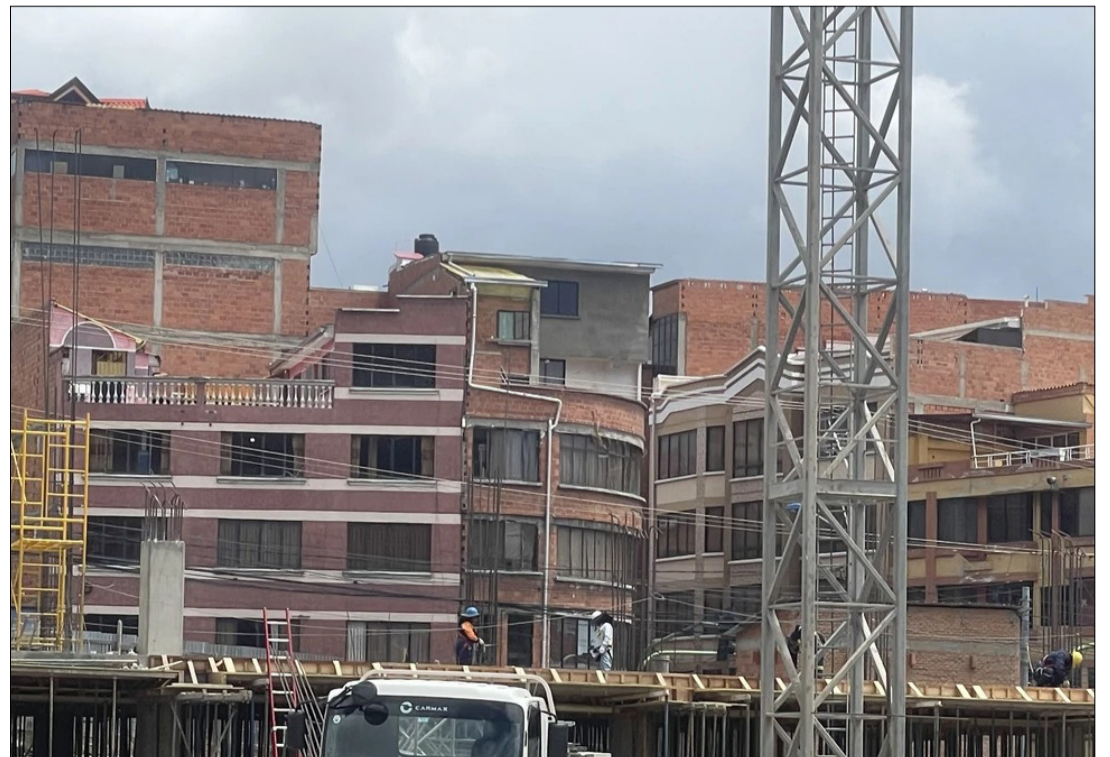
EL AVANCE DE OBRAS EN EL ESTADIO DE BOLÍVAR SERÁ “MÁS VISUAL”. FOTO: JORGE ASTURIZAGA
