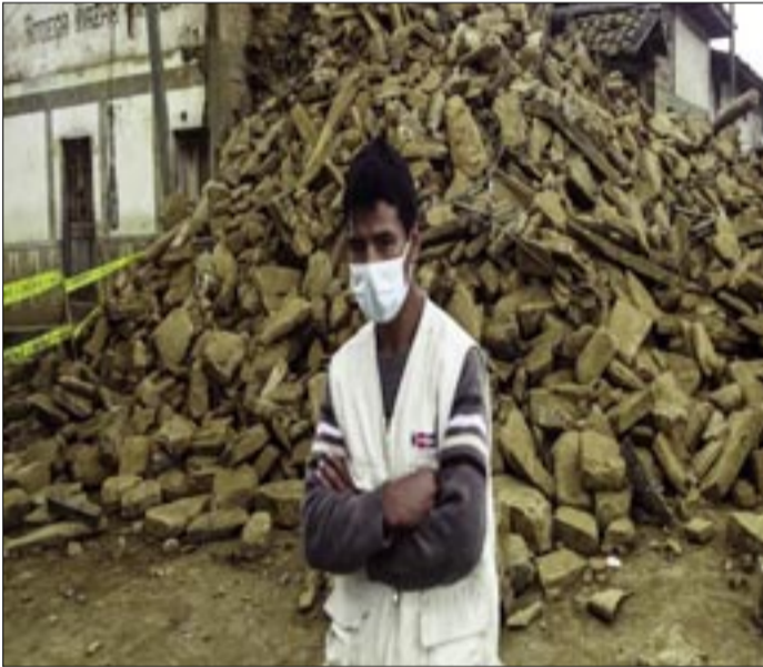
EL TERREMOTO OCASIONÓ DAÑOS EN EL PRINCIPAL HOSPITAL DE LA CIUDAD, AL IGUAL QUE EN ESCUELAS Y CASAS. (IMAGEN DE ARCHIVO 28.11.2021)
