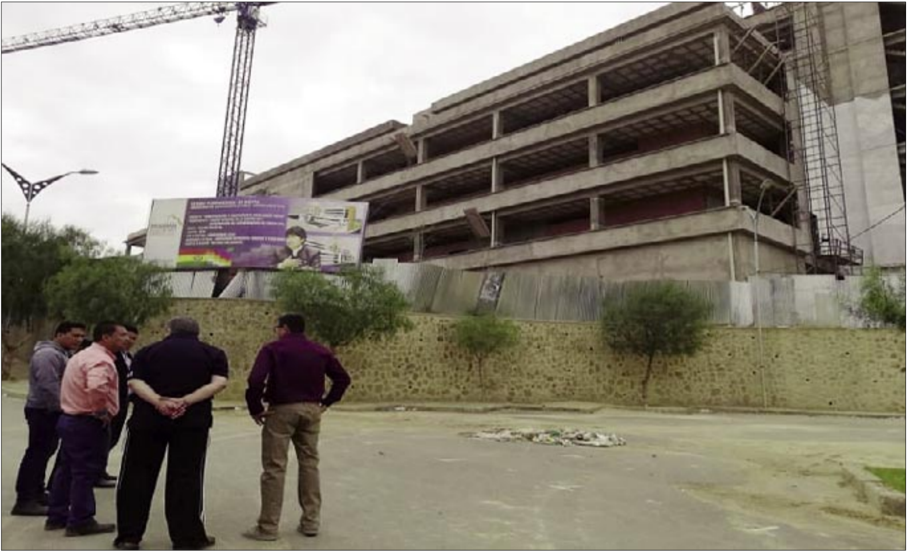
PESE A GESTIONES, AVANCES Y TRABAJOS EL ONCOLÓGICO NO SE CONCLUYE.
