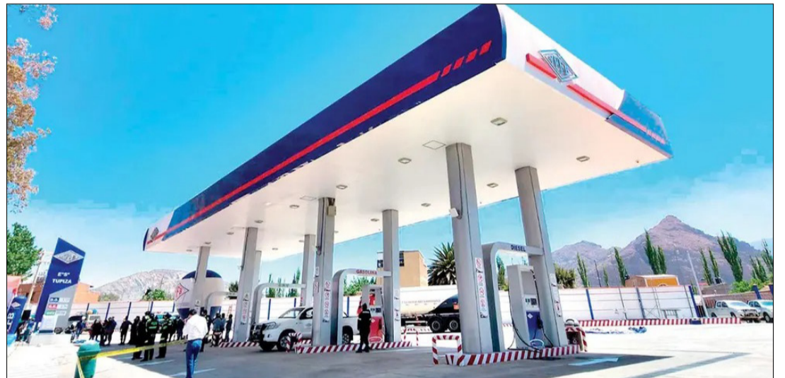
UNA ESTACIÓN DE SERVICIO DE VENTA DE GASOLINA Y DIÉSEL. / YPFB/ABI
