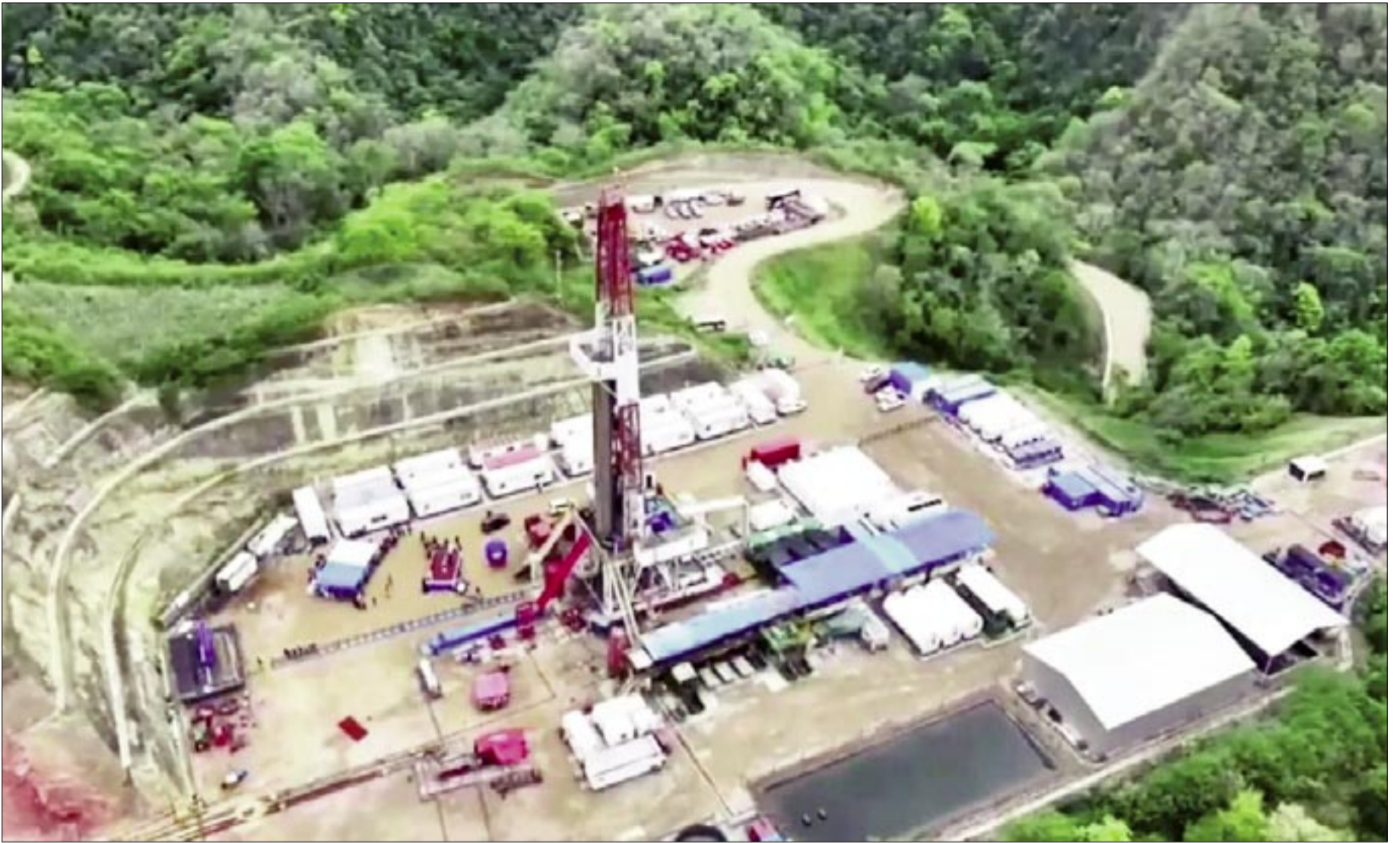
YPFB RETIRA EQUIPO DE PERFORACIÓN DE BERMEJO.
