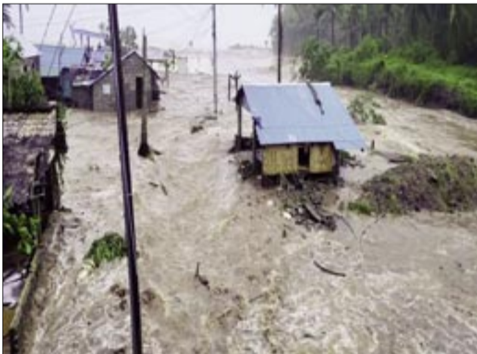
AUNQUE EL TIFÓN HA PERDIDO ALGO DE FUERZA, LOS VIENTOS FUERON INTENSOS EN LA PROVINCIA FILIPINA DE LUZÓN, PROVOCANDO INUNDACIONES, DAÑOS CONSIDERABLES A LA INFRAESTRUCTURA, CAÍDA DE ÁRBOLES Y CORTES ELÉCTRICOS GENERALIZADOS.
