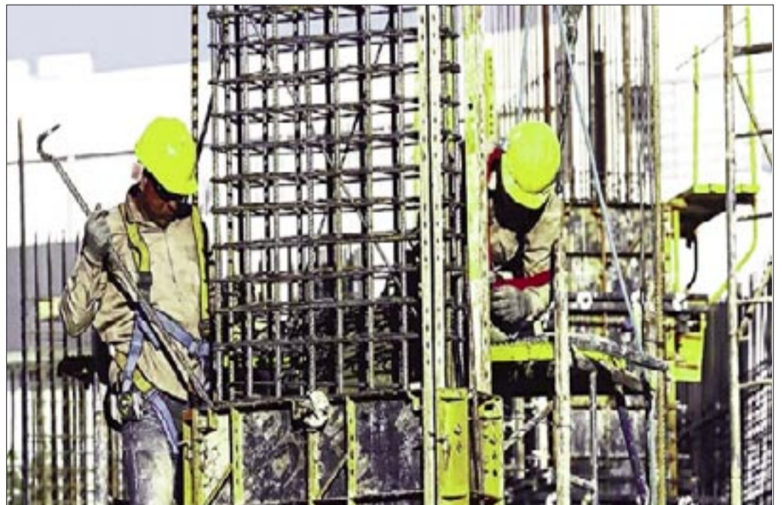
DOS OBREROS TRABAJAN EN UNA CONSTRUCCIÓN. FOTO: ARCHIVO
