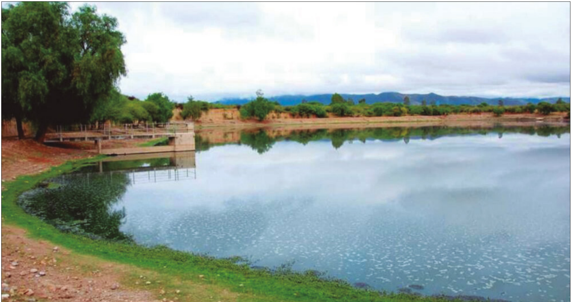
EL FINANCIAMIENTO DE LA CAF, TAMBIÉN PREVÉ EL CIERRE DE LAS LAGUNAS DE OXIDACIÓN DE SAN LUIS.
