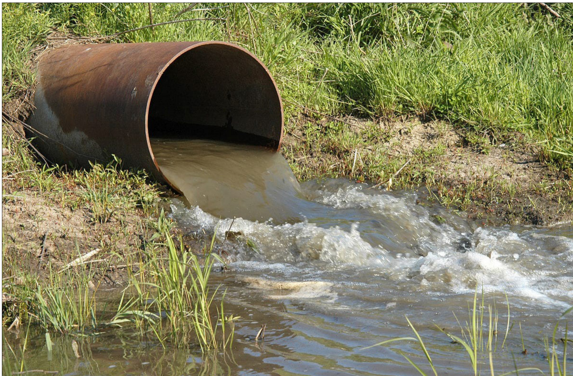
AGUAS RESIDUALES CONTINÚAN CONTAMINANDO LAS QUEBRADAS, CADA VEZ MÁS.
