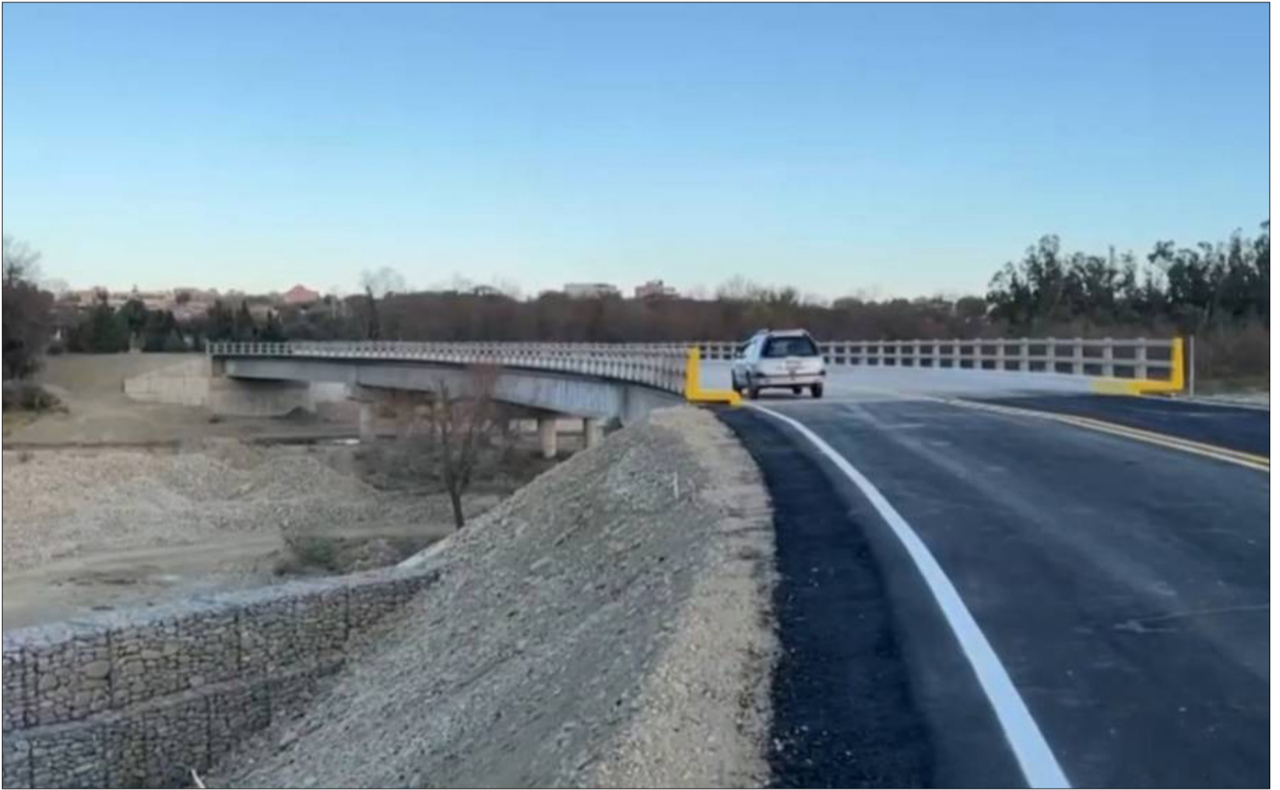
ESTE PUENTE SERÁ INAUGURADO OFICIALMENTE HOY.
