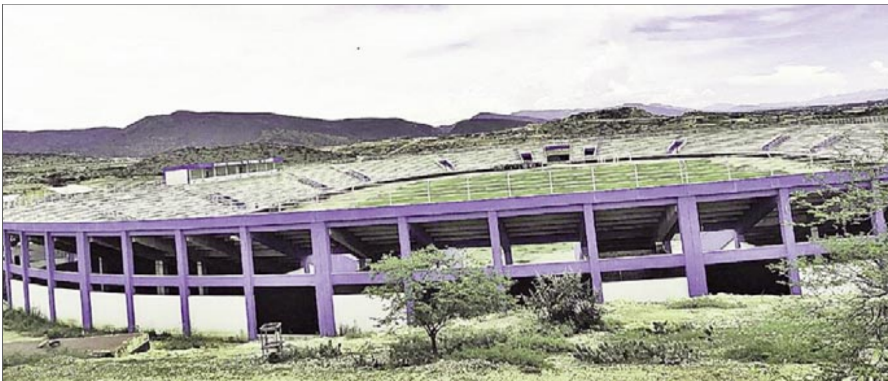
PROYECTOS EJECUTADOS EN LA PROVINCIA O'CONNOR
