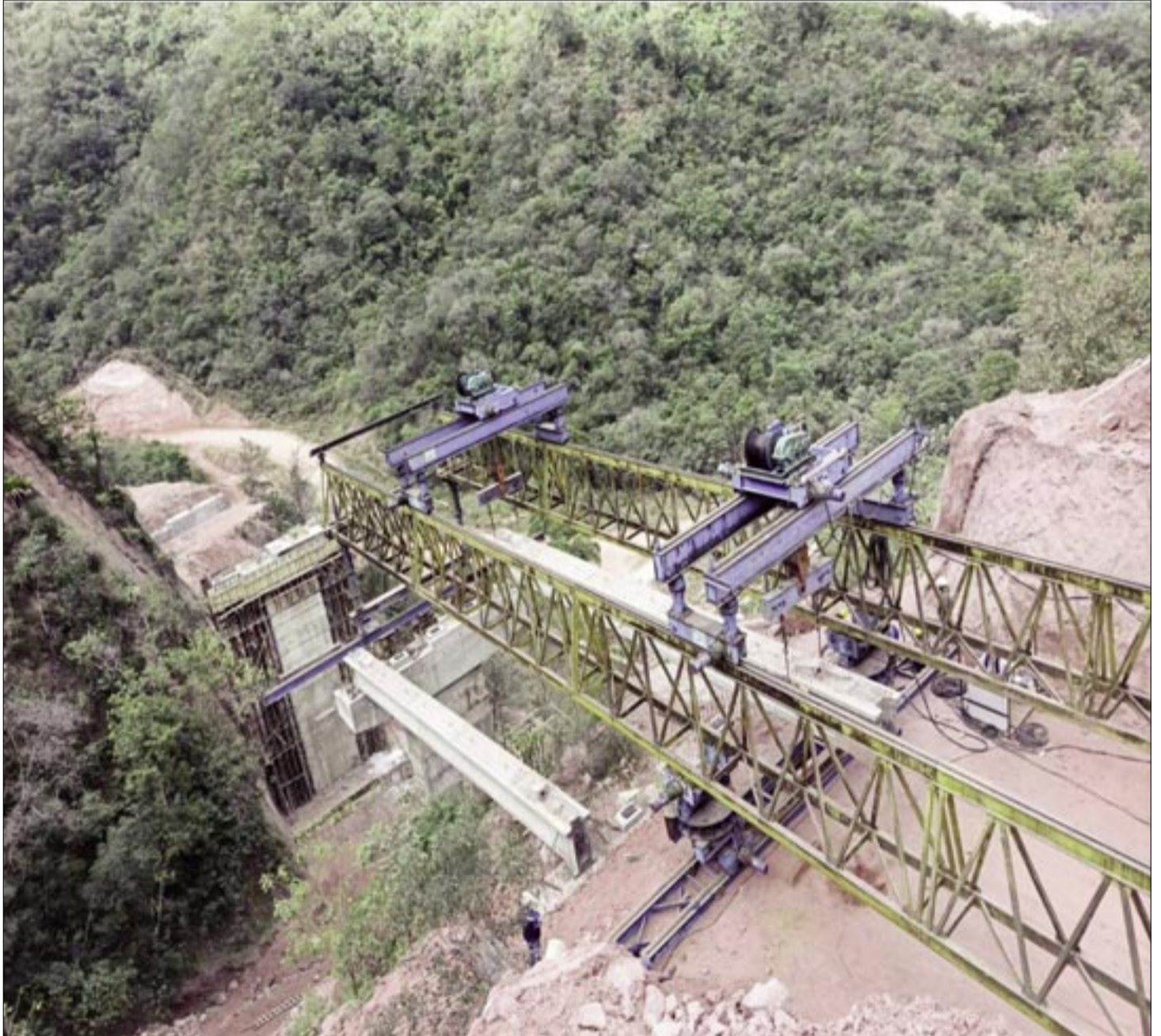
OBRAS EN EJECUCIÓN EN TRAMO CARRETERO CHOERE-ACHERAL
