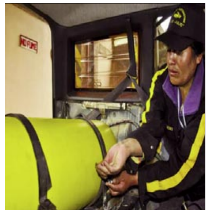
INSTALACIÓN DE EQUIPOS DE GAS NATURAL VEHICULAR
