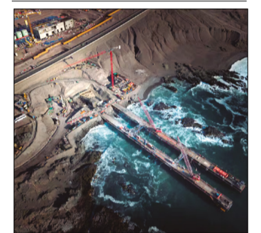
EL MEGAPROYECTO DE TECHINT EN CHILE QUE LLEVARÁ AGUA DEL PACÍFICO A LAS MINAS DE COBRE
