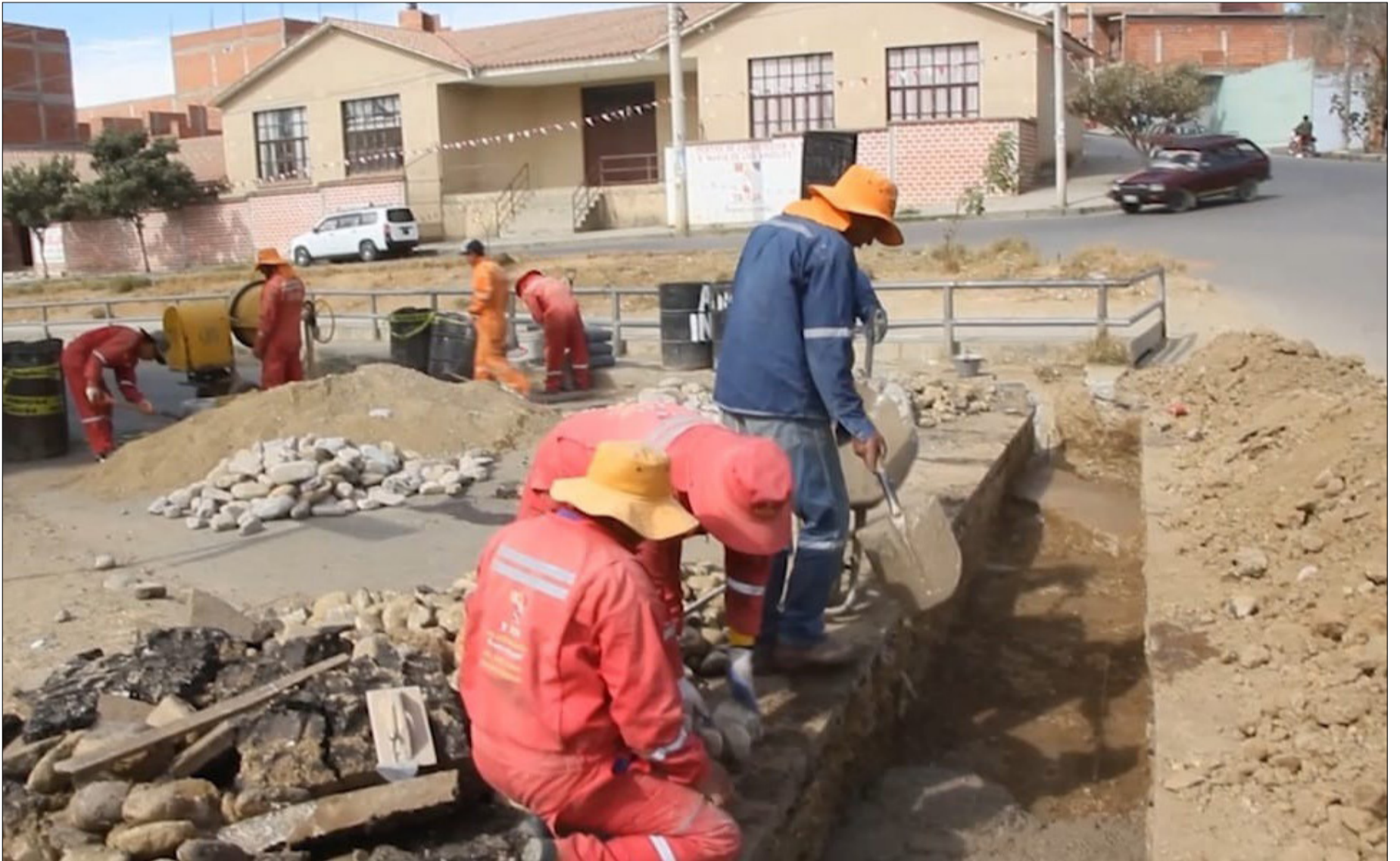
ACELERAN LIMPIEZA DEL SISTEMA DE DRENAJE DE LA CIUDAD.
