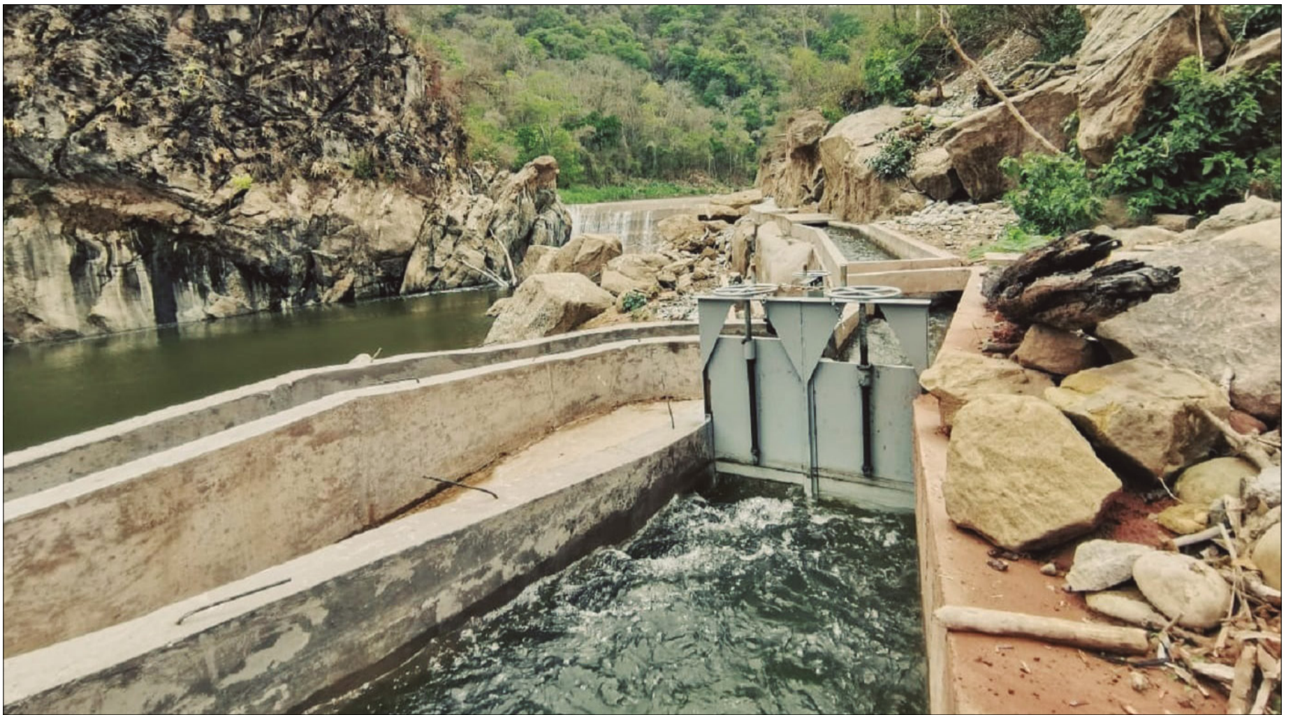
UNA PARTE DEL PROYECTO DE ADUCCIÓN SAN TELMO, PARA BERMEJO.
