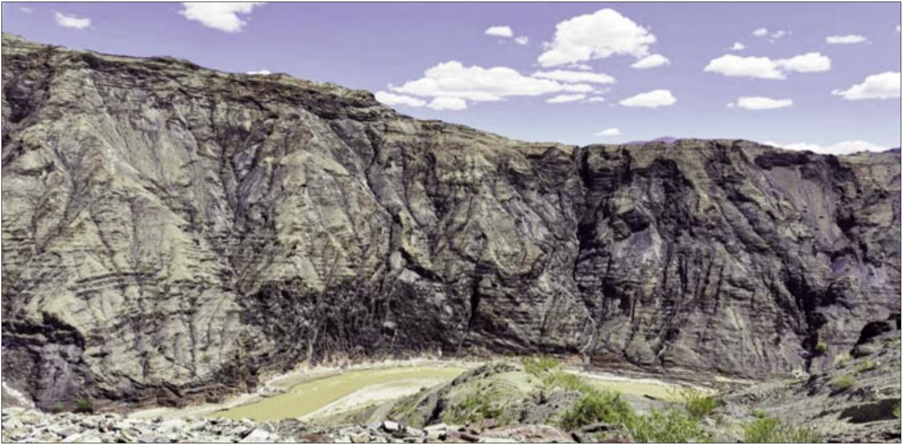
PROYECTO HIDROELECTRICO CARRIZAL, IMAGEN REFERENCIAL
