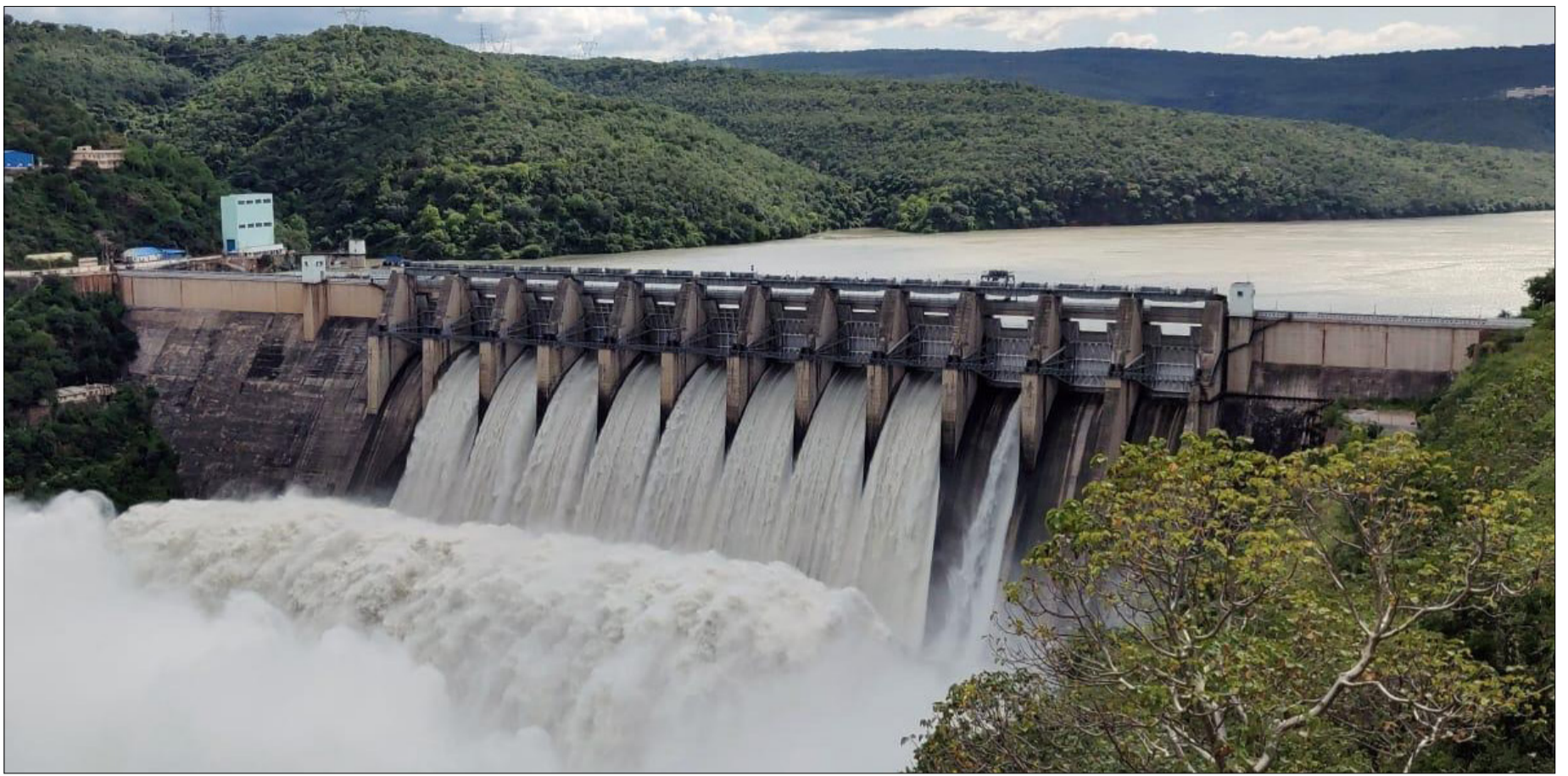
PLANTA HIDROELÉCTRICA (REF).
