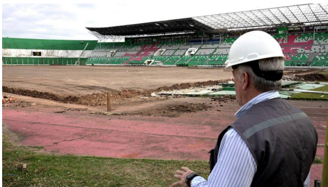
LOS TRABAJOS DEL ESTADIO TAHUCHI AGUILERA ESTAN RETRASADOS SEGUN LA COMISIÓN DE LA CONMEBOL.
